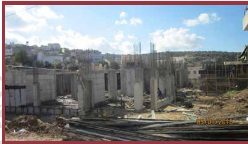
اعمال البناء في محكمة سلفيت
